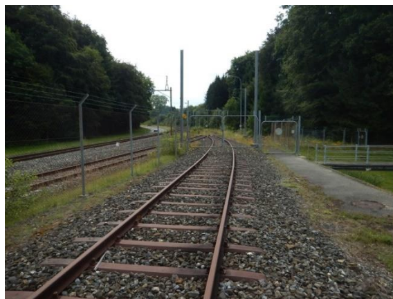
Vue du raccordement au réseau ferroviaire
