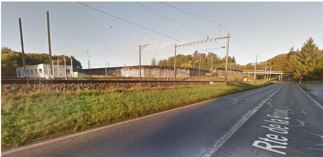
Figure 6-17: vue sur le bâtiment existant et le mur de quais depuis la route cantonale – google street View, 2020
