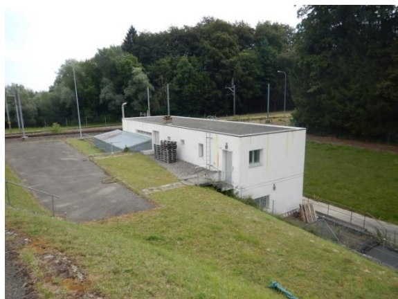
Vue du bâtiment technique
