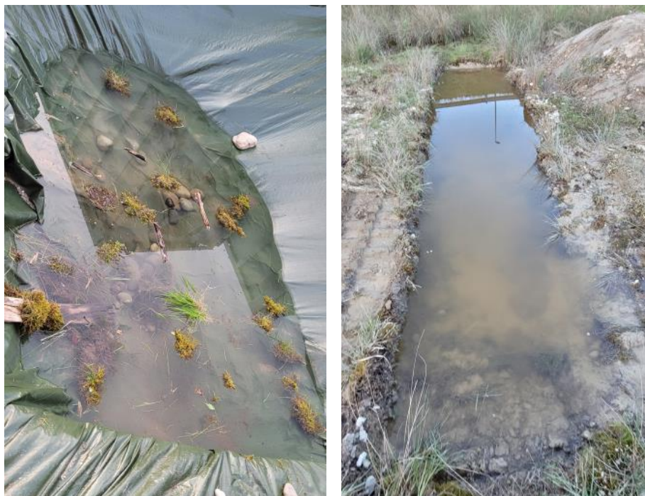
Figure 6-15 Aménagement d'une bâche qui a permis la création d'un petit étang (à gauche) ; Utilisation des sondages à la pelle pour réaliser des étangs temporaires (à droite)
