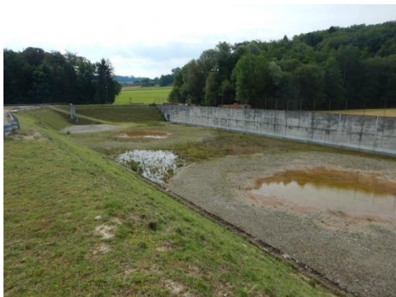
Vue du bassin n°3
